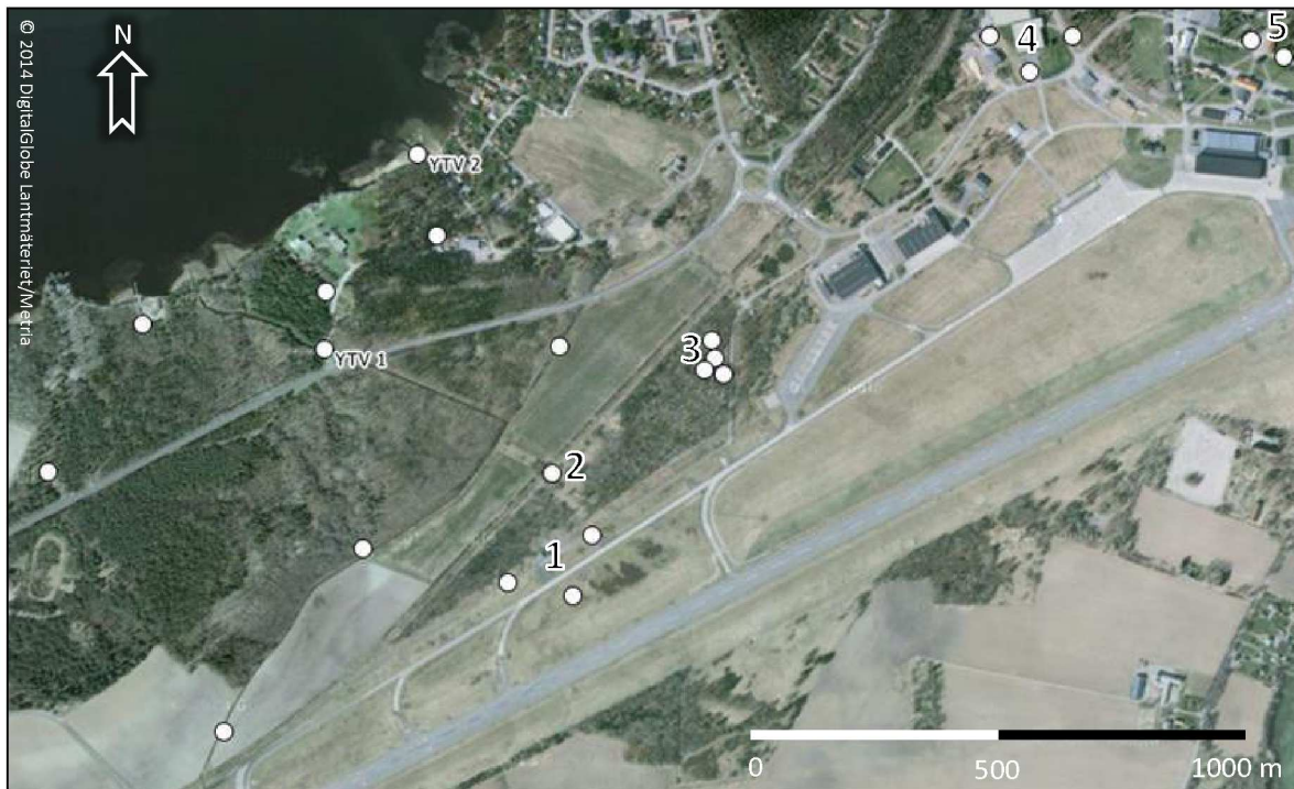
Figur 1. Undersökta områden samt punkter i den bedömda strömningsriktningen för grundvatten; 1. Nya brandövningsplatsen, 2. Pumphuset, 3. Gamla brandövningsplatsen, 4. Byggnad 148, 5. Gamla brandstationen. Vita prickar = grundvattenprov, YTV1-YTV2= ytvattenprov.
