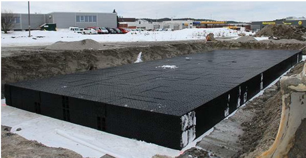
Figur 1. Fördröjningsmagasin av plastkassetter.
