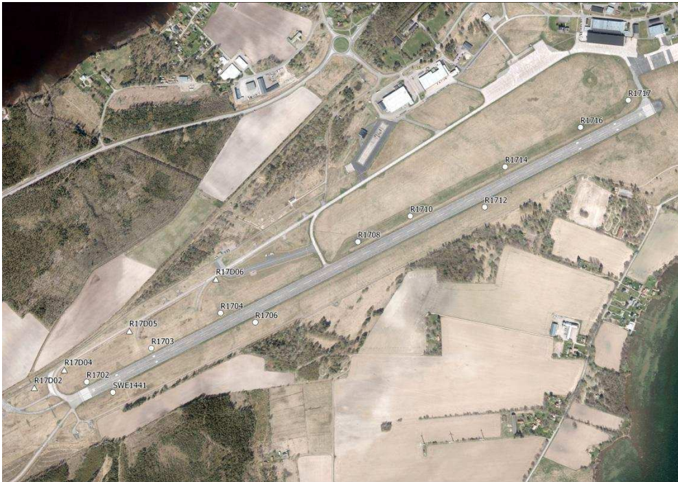
Figur 5. Lokalisering av provtagningspunkter för jord och vatten i anslutning till rullbanan. Vita cirkelar visar punkter för jordprovtagning där även grundvattenrör installerats och vita trianglar visar provtagningspunkter för dagvatten i befintliga dagvattenbrunnar. Se även Bilaga A. för placering av provtagningspunkter (större bild).
